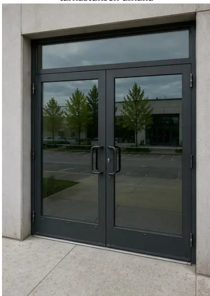
Photo #7. Ovien kunto tarkastettu ja kirjattu
