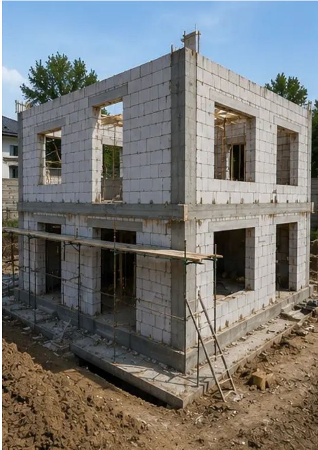
Kuva №7 Ulkoseinien rakentaminen valmis rakennusosiolle
