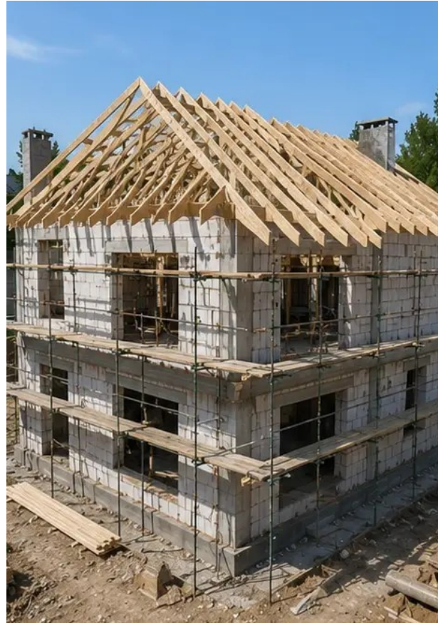
Kuva №8 Katon asennustyöt valmiit
