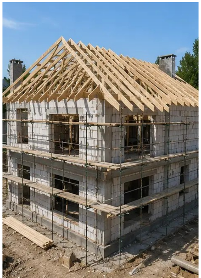
Kuva №8 Katon asennustyöt valmiit
