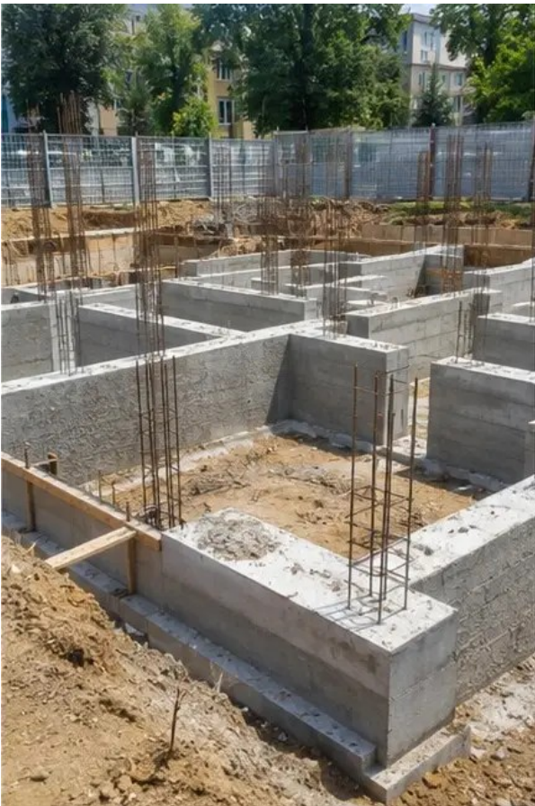
Kuva №3 Perustusten rakentaminen käynnissä
