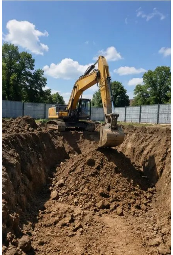
Kuva №2 Kaivutyöt suoritettu projektin vaatimusten mukaisesti
