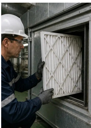
Kuva №7. Ilmansuodattimen vaihto valmis
