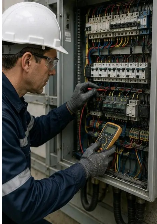
Kuva №5. Sähkökaapin tarkastus suoritettu
