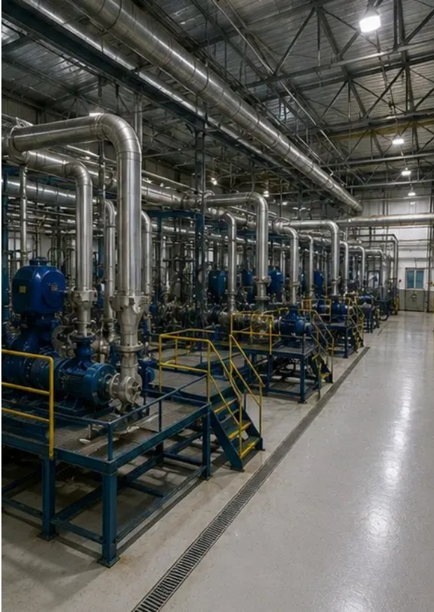
Kuva №16. Yleiskuva laitoksesta huoltotöiden valmistumisen jälkeen
