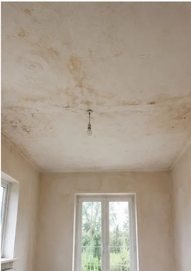
Kuva №7 Katon kunto ennen remonttia
