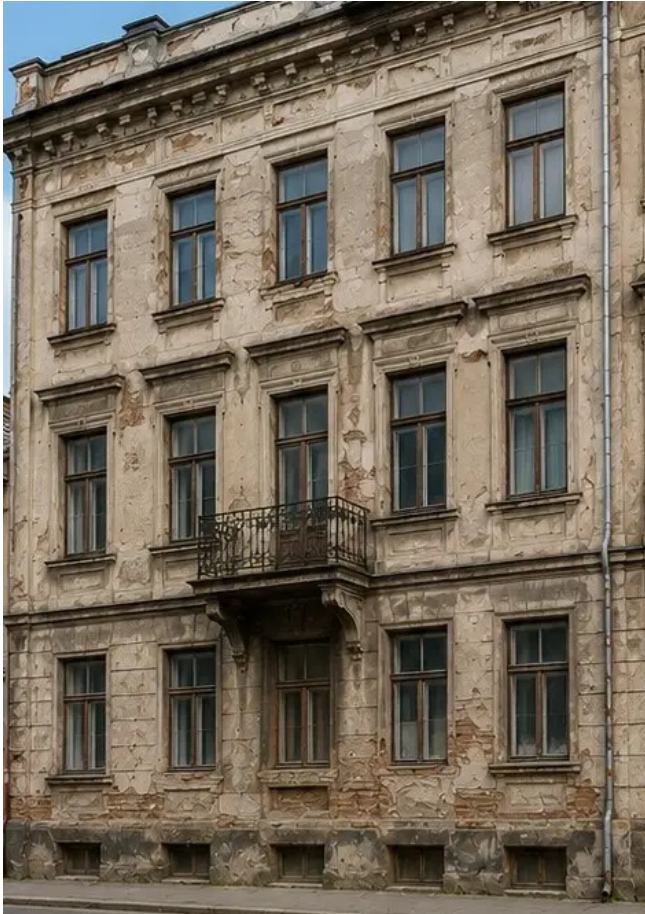
Kuva №13 Rakennuksen julkisivu ennen restaurointitöitä
