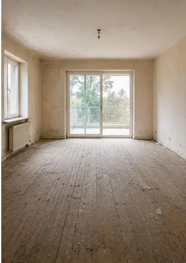
Kuva №1 Olohuoneen kunto ennen remonttia
