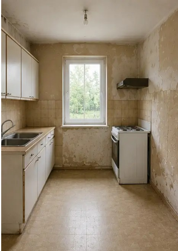
Kuva №11 Keittiön kunto ennen remonttia
