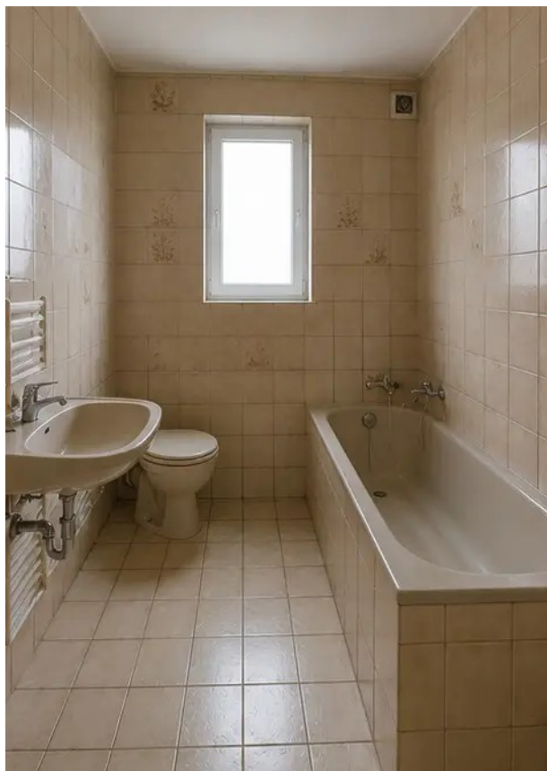
Kuva №9 Kylpyhuoneen kunto ennen remonttia
