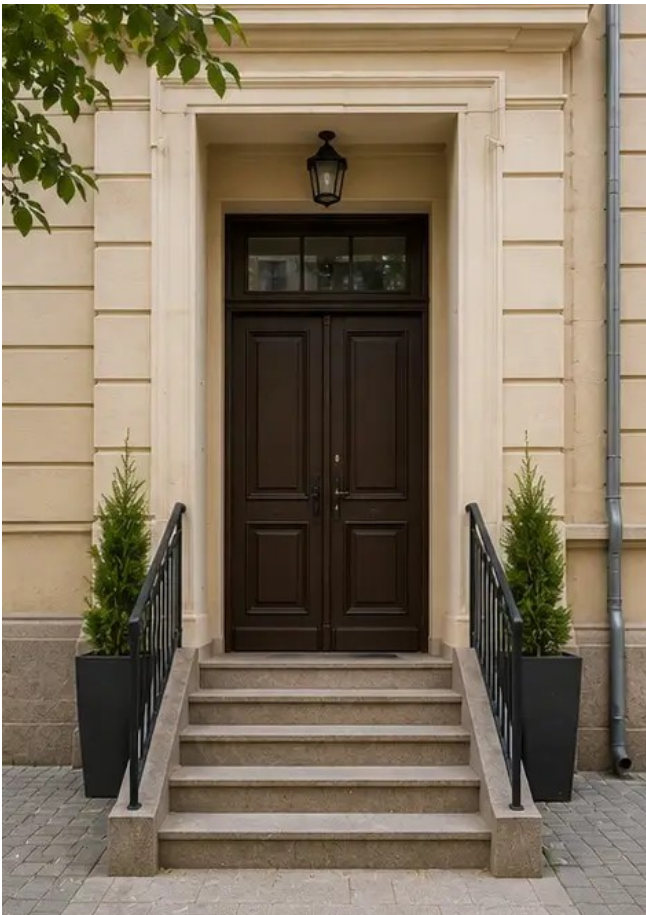
Kuva №16 Kiinteistön sisäänkäynti parannuksen jälkeen
