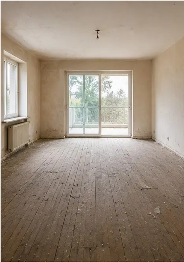
Kuva №1 Olohuoneen kunto ennen remonttia
