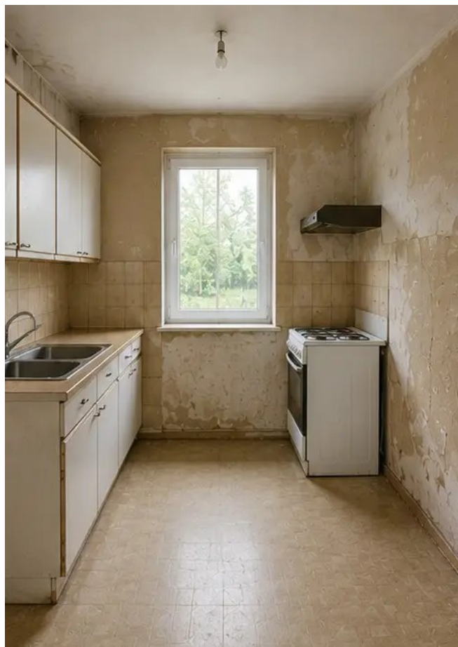
Kuva №11 Keittiön kunto ennen remonttia
