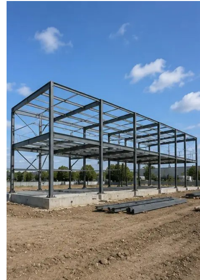
Foto No7. Construcción de la estructura portante en curso
