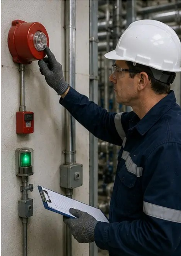
Foto №13. Inspección del sistema de seguridad completada
