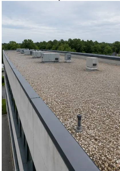
Photo #5. Inspección del estado del techo completada
