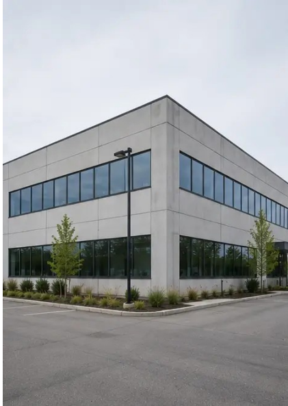
Photo #1. Vista general de la propiedad inspeccionada
