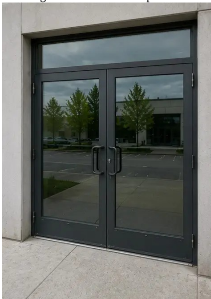
Photo #7. Estado de las puertas inspeccionado y registrado
