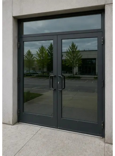
Photo #7. Estado de las puertas inspeccionado y registrado
