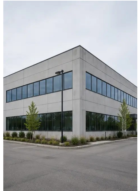
Photo #1. Vista general de la propiedad inspeccionada
