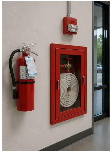
Photo #12. Equipo de seguridad inspeccionado y registrado
