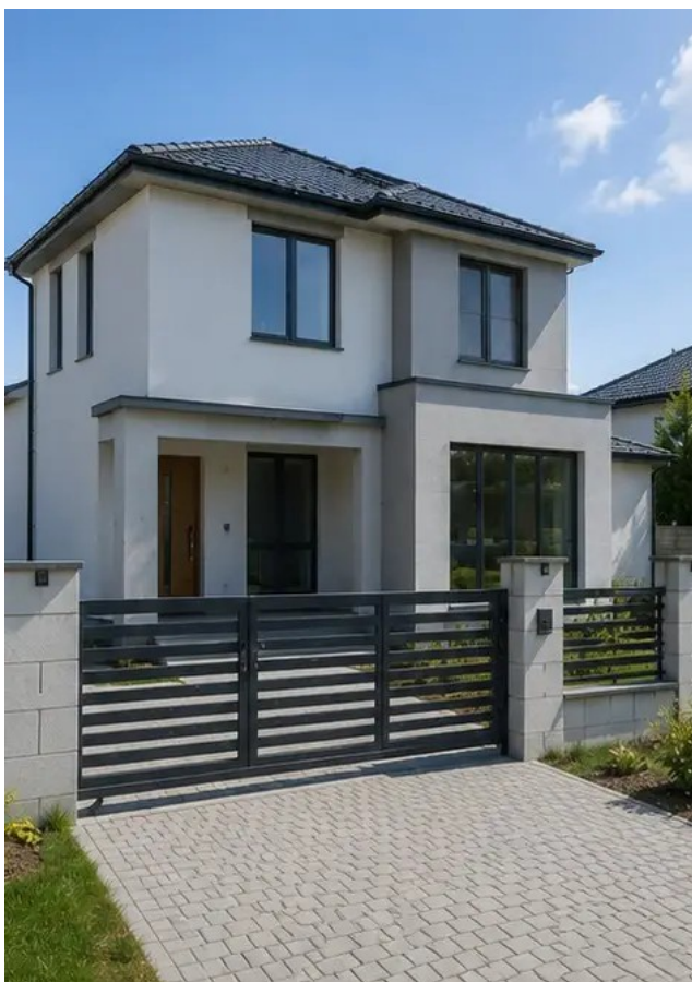
Foto №15 Exterior del edificio terminado después de la construcción
