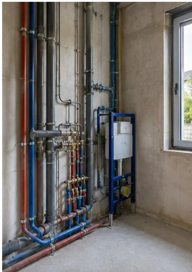
Foto №10 Instalación de sistemas de plomería completada en áreas designadas
