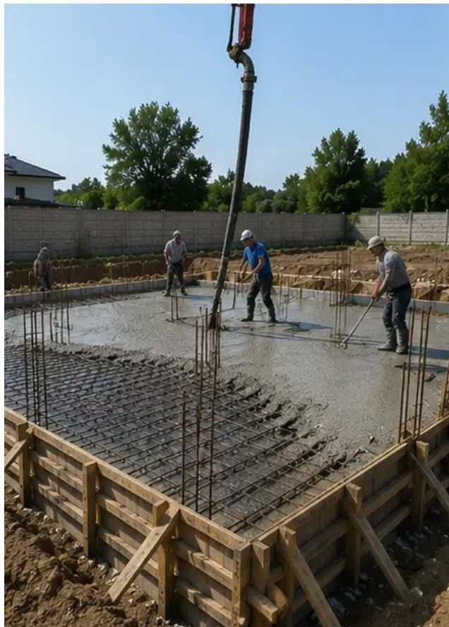
Foto №5 Vertido de hormigón realizado en elementos de cimentación
