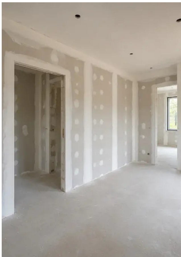
Foto №11 Trabajos de acabado de paredes interiores en curso
