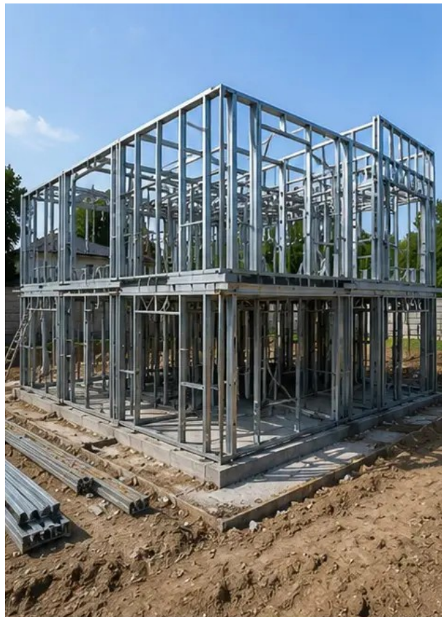
Foto №6 Montaje de la estructura portante en curso
