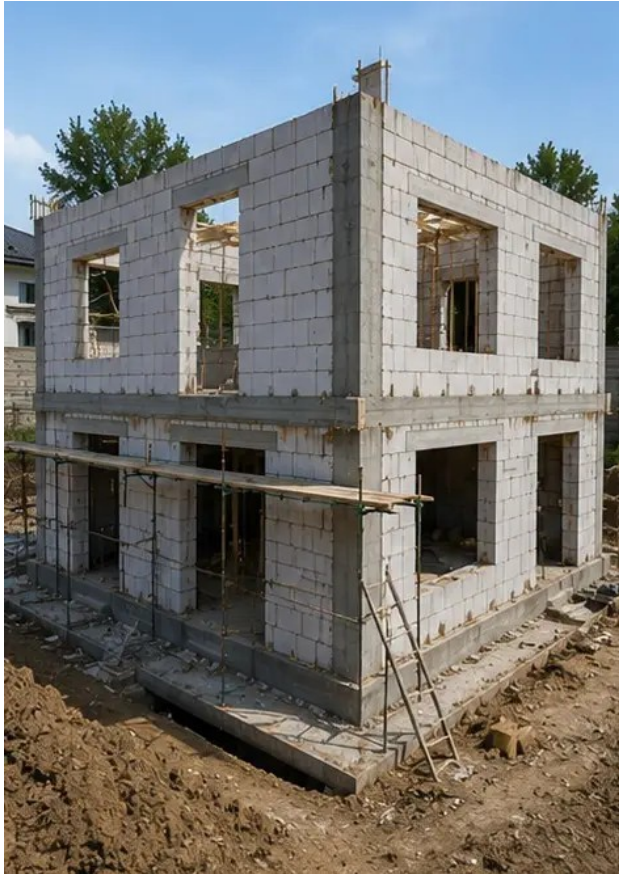
Foto №7 Construcción de muros exteriores completada para la sección del edificio
