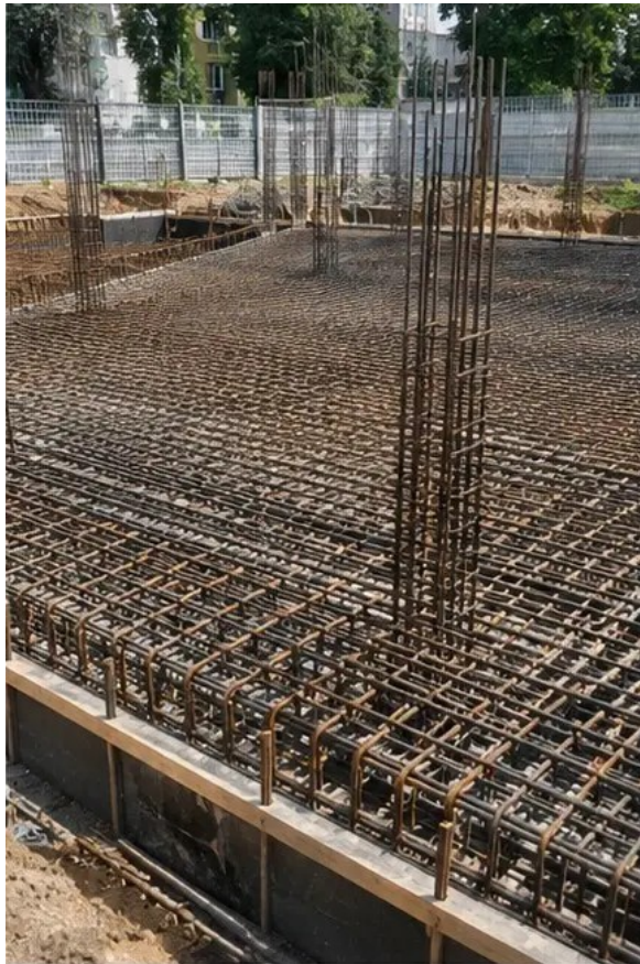
Foto №4 Instalación de refuerzo completada antes del vertido de hormigón
