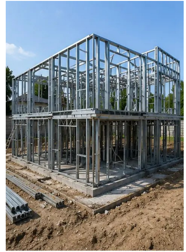
Foto №6 Montaje de la estructura portante en curso
