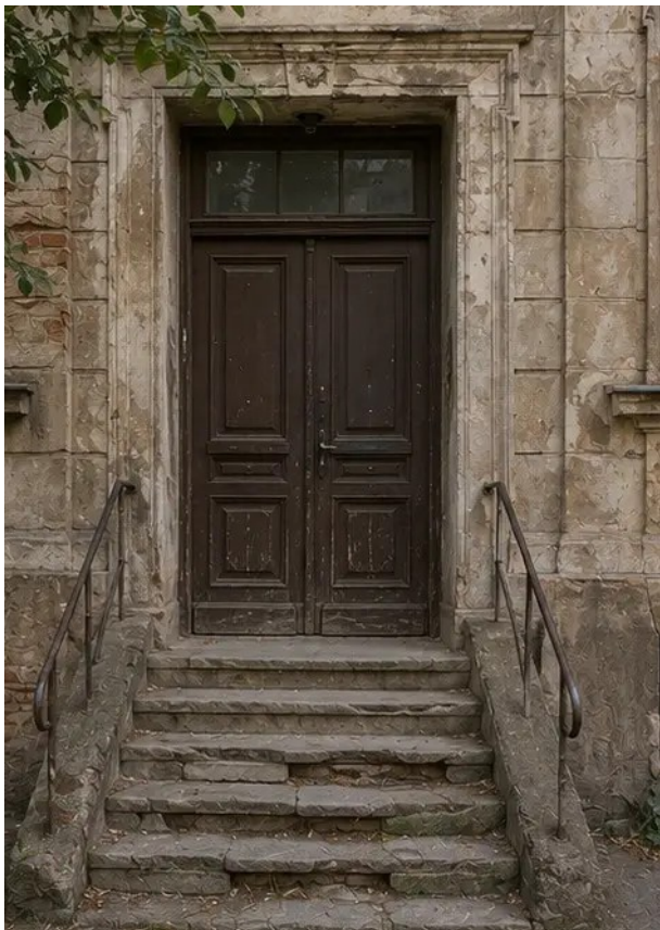
Foto №15 Entrada de la propiedad antes de la mejora
