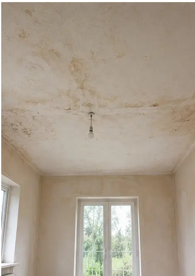
Foto Nº7 Estado del techo antes de la renovación
