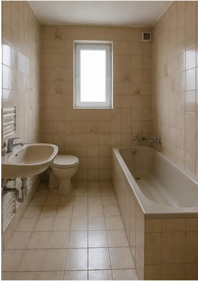
Foto №9 Estado del baño antes de la renovación
