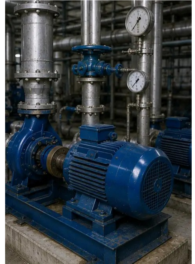
Φωτογραφία Νο15. Ο εξοπλισμός λειτουργεί κανονικά μετά τη συντήρηση
