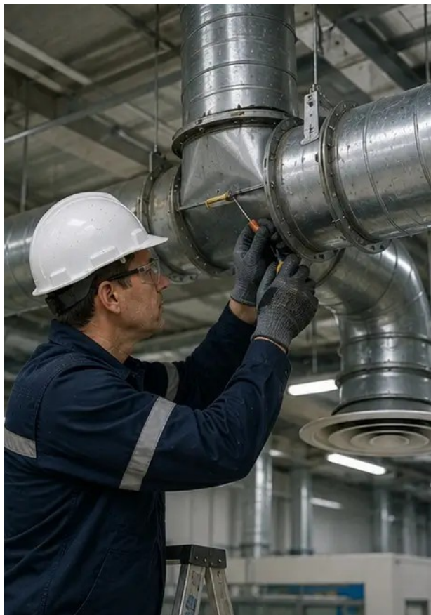
Φωτογραφία Νο8. Συντήρηση συστήματος αερισμού ολοκληρώθηκε
