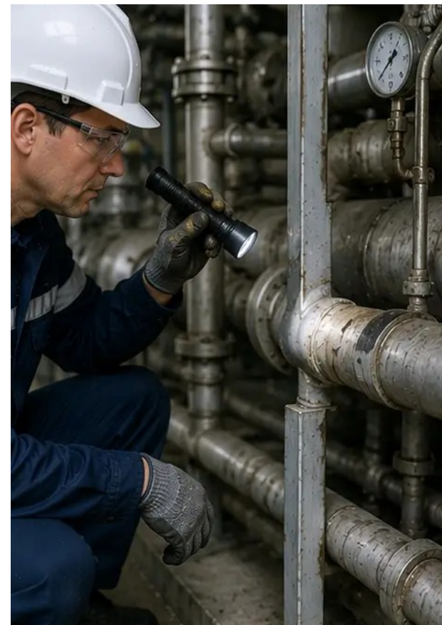
Φωτογραφία Νο9. Επιθεώρηση σωληνώσεων ολοκληρώθηκε σύμφωνα με το πρόγραμμα συντήρησης
