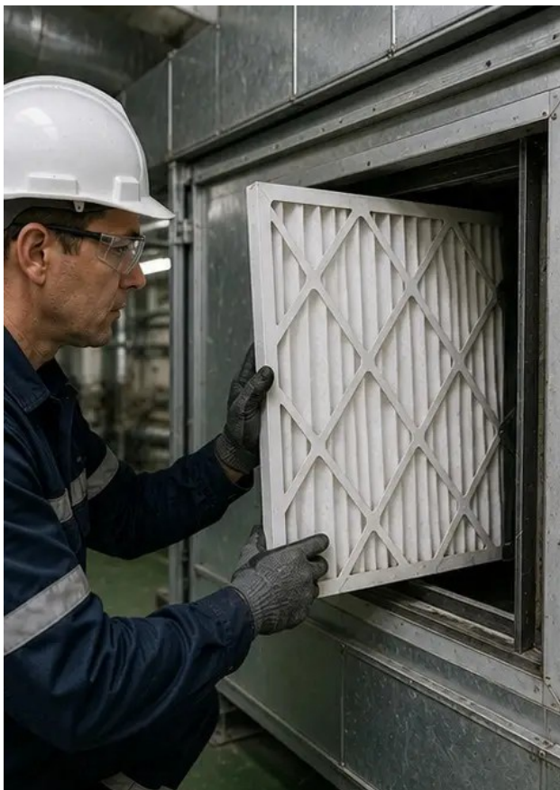
Φωτογραφία Νο7. Αντικατάσταση φίλτρου αέρα ολοκληρώθηκε
