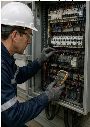
Φωτογραφία Νο5. Επιθεώρηση ηλεκτρικού πίνακα πραγματοποιήθηκε
