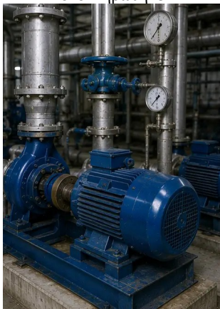
Φωτογραφία Νο15. Ο εξοπλισμός λειτουργεί κανονικά μετά τη συντήρηση
