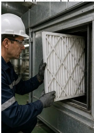
Φωτογραφία Νο7. Αντικατάσταση φίλτρου αέρα ολοκληρώθηκε
