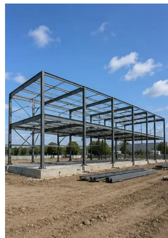
Φωτογραφία Νο7. Κατασκευή φέροντος σκελετού σε εξέλιξη
