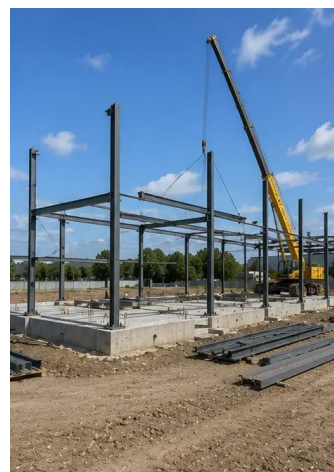
Φωτογραφία Νο6. Ξεκίνησε η συναρμολόγηση φέροντος σκελετού
