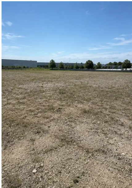
Φωτογραφία Νο5. Κατασκευή θεμελίων ολοκληρώθηκε
