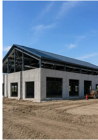
Φωτογραφία №10. Κατασκευή στέγης ολοκληρώθηκε
