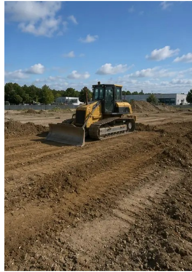
Φωτογραφία Νο2. Δραστηριότητες προετοιμασίας εργοταξίου σε εξέλιξη
