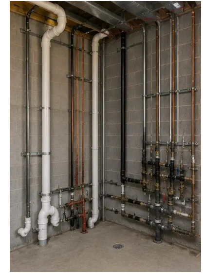
Φωτογραφία №12. Εγκατάσταση υδραυλικών συστημάτων ολοκληρώθηκε
