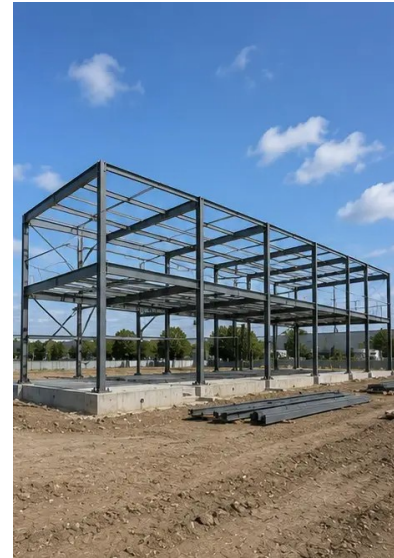
Φωτογραφία Νο7. Κατασκευή φέροντος σκελετού σε εξέλιξη
