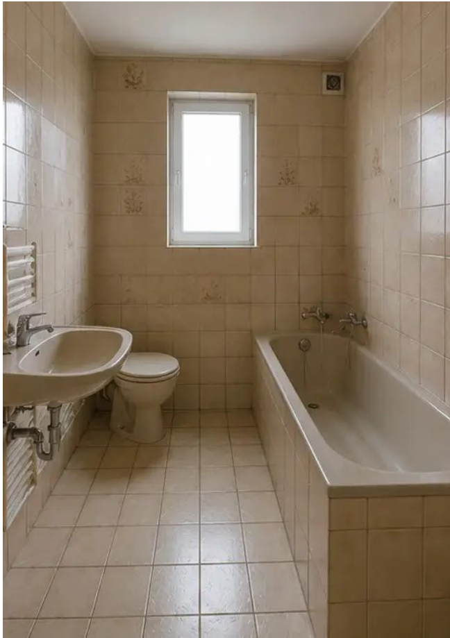
Φωτογραφία №9 Κατάσταση μπάνιου πριν την ανακαίνιση
