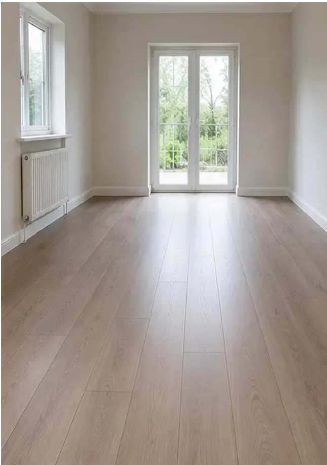
Φωτογραφία №6 Κατάσταση δαπέδου μετά την αντικατάσταση
