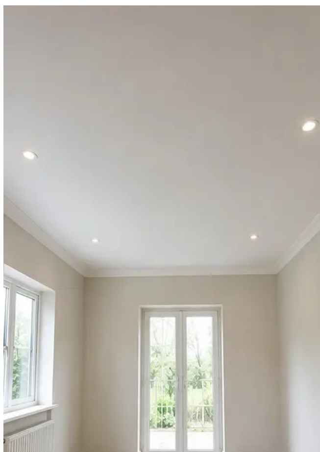
Φωτογραφία №8 Κατάσταση οροφής μετά την ανακαίνιση
