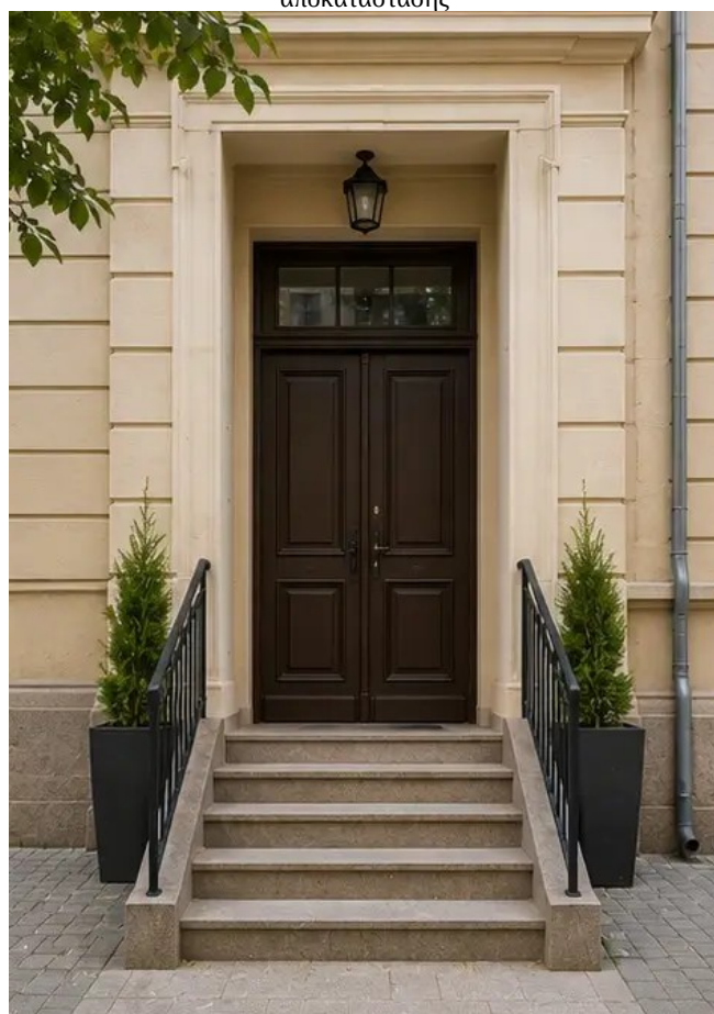
Φωτογραφία Νο16 Property entrance after improvement
