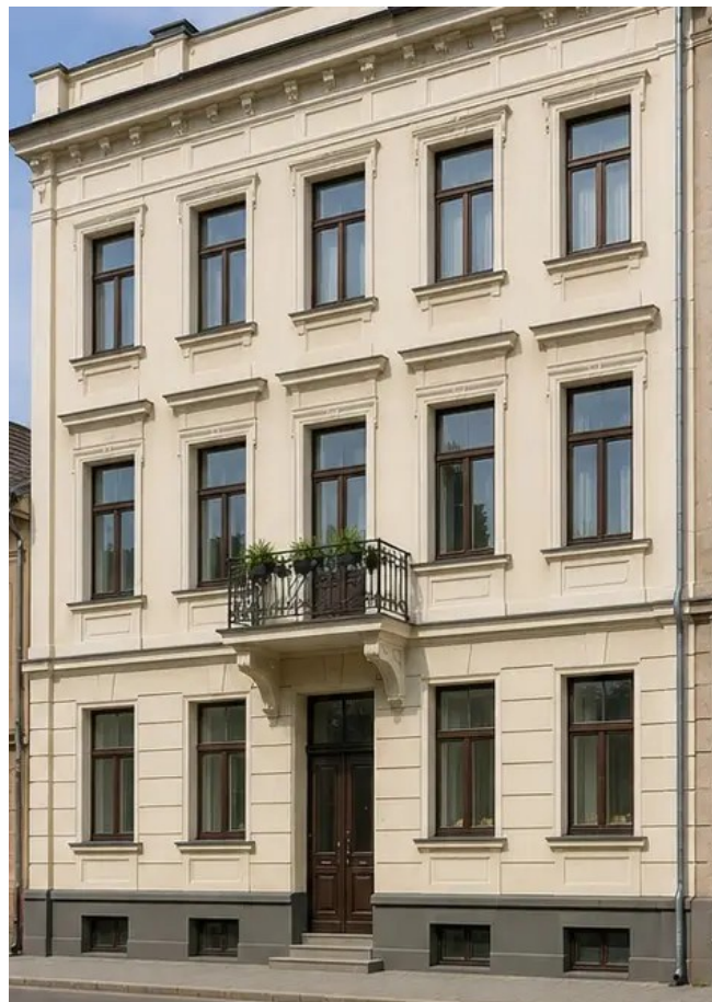
Φωτογραφία Νο14 Πρόσοψη κτιρίου μετά τις εργασίες αποκατάστασης
