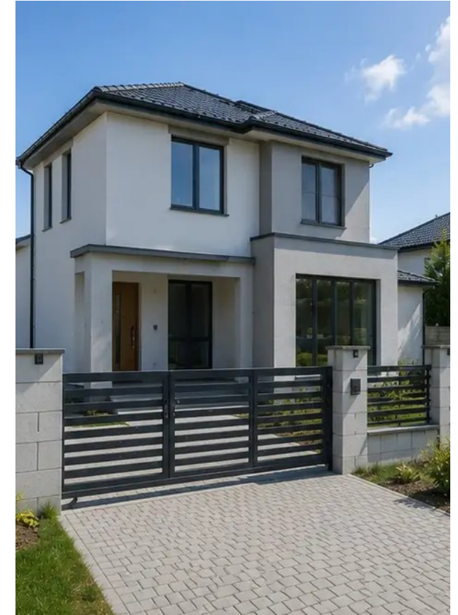
Φωτογραφία Νο15 Ολοκληρωμένο εξωτερικό κτιρίου μετά την κατασκευή
