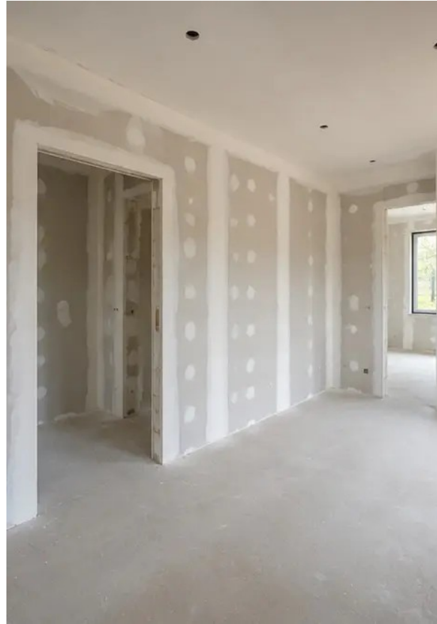
Φωτογραφία Νο11 Εργασίες φινιρίσματος εσωτερικών τοίχων σε εξέλιξη
