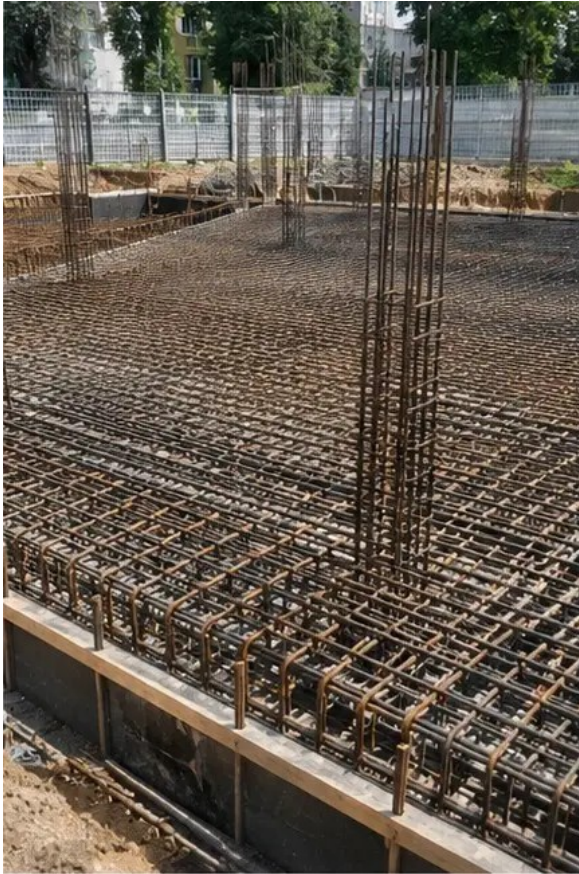
Φωτογραφία Νο4 Εγκατάσταση σπλισμού ολοκληρώθηκε πριν τη σκυροδέτηση
