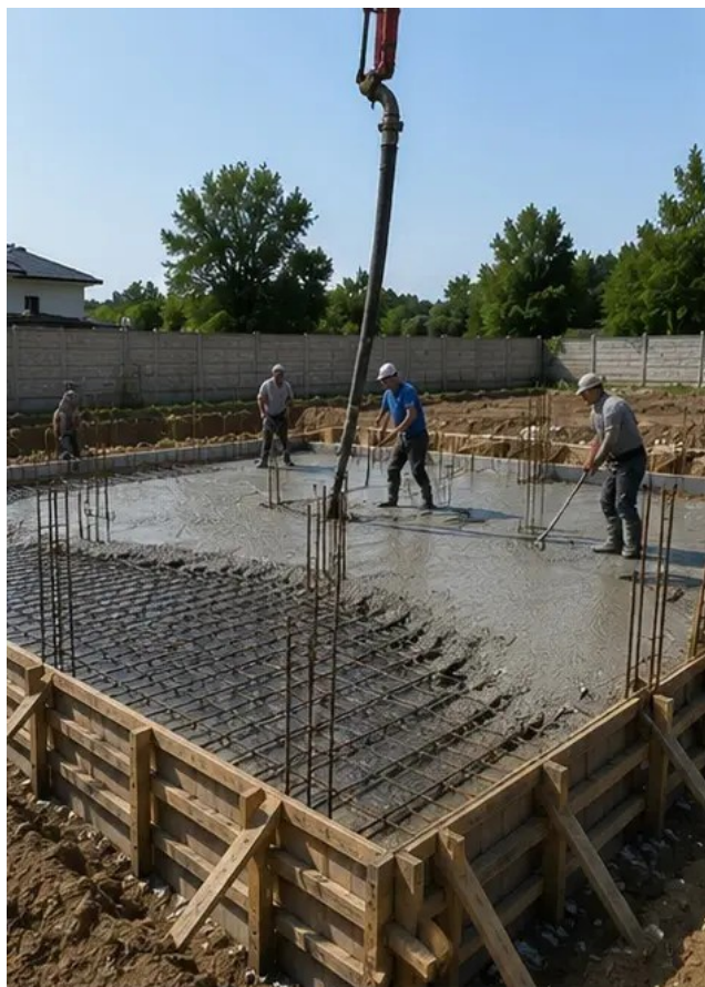
Φωτογραφία Νο5 Διαδικασία σκυροδέτησης εκτελέστηκε σε στοιχεία θεμελίωσης
