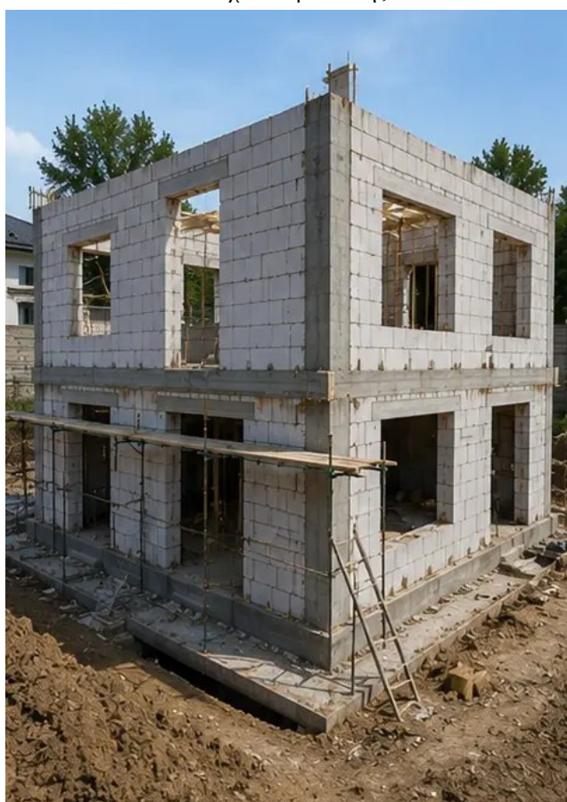
Φωτογραφία Νο7 Κατασκευή εξωτερικών τειχών ολοκληρώθηκε για το τμήμα κτιρίου
