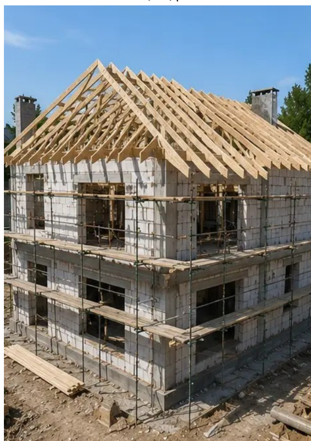
Φωτογραφία Νο8 Εργασίες εγκατάστασης στέγης ολοκληρώθηκαν
