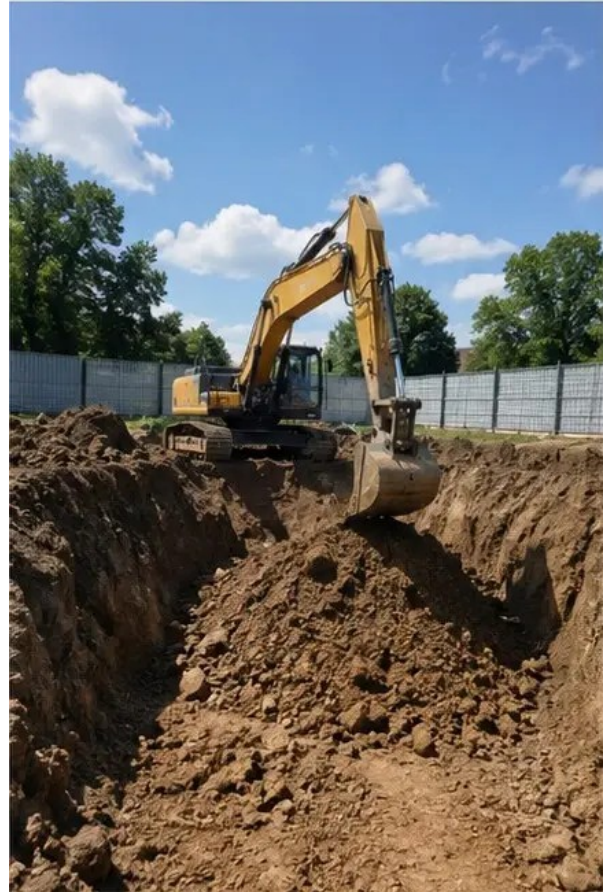
Φωτογραφία Νο2 Εκσκαφικές εργασίες εκτελέστηκαν σύμφωνα με τις απαιτήσεις του έργου
