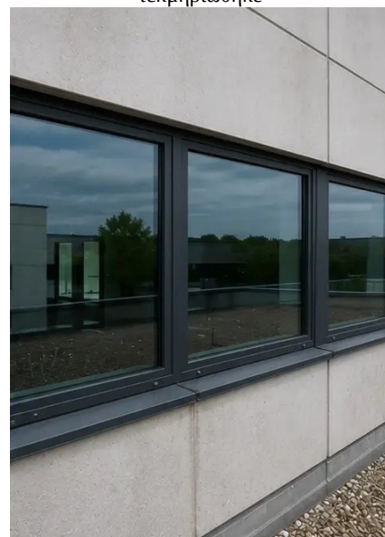
Photo #6. Κατάσταση κουφωμάτων τεκμηριώθηκε κατά την επιθεώρηση
