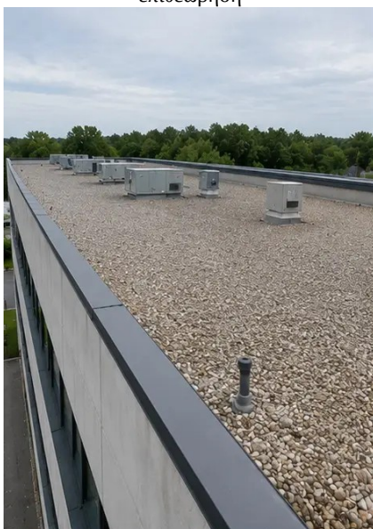
Photo #5. Έλεγχος κατάστασης στέγης ολοκληρώθηκε
