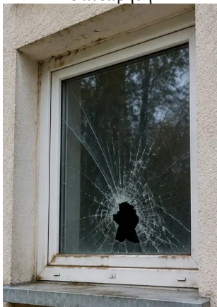
Photo #7. Κατεστραμμένο παράθυρο τεκμηριώθηκε για αξιολόγηση
