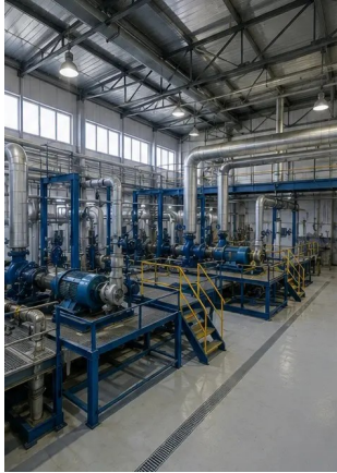
Foto №1. Gesamtüberblick über die Industrieanlage
