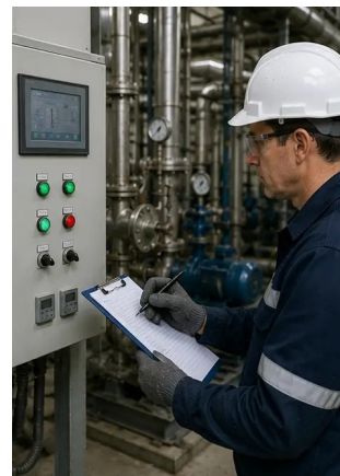
Foto №14. Abschließende Wartungsüberprüfung durchgeführt
