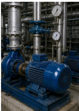
Foto №15. Ausrüstung nach der Wartung normal in Betrieb
