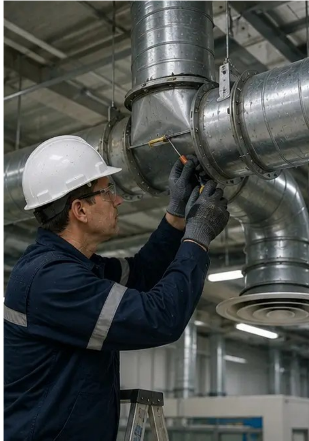
Foto №8. Wartung des Lüftungssystems abgeschlossen
