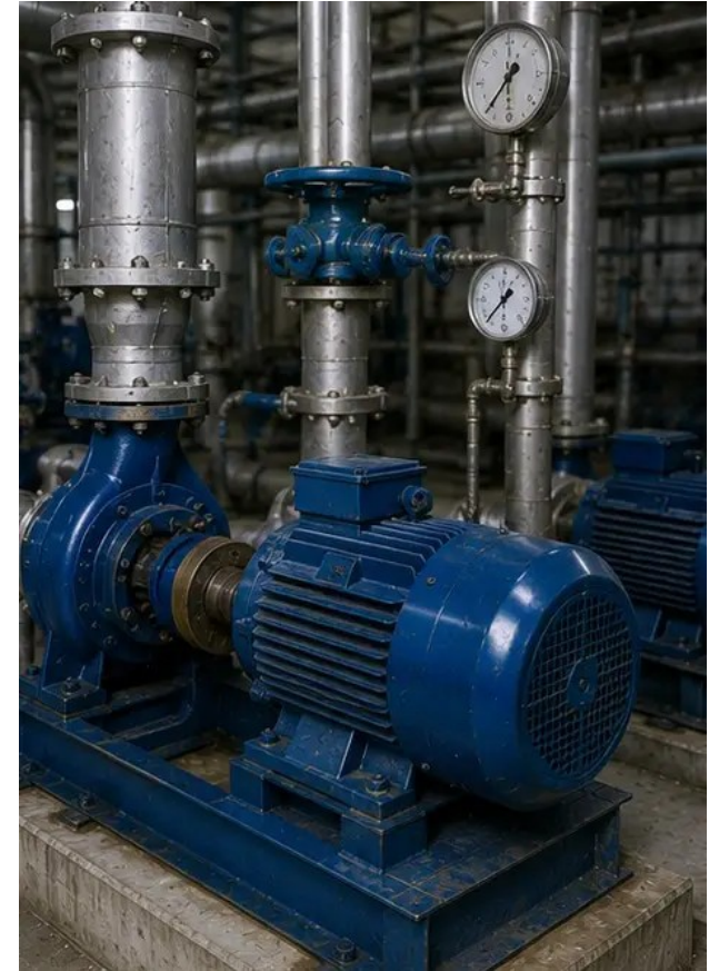
Foto №15. Ausrüstung nach der Wartung normal in Betrieb
