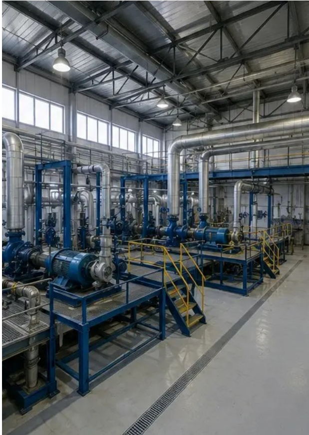
Foto №1. Gesamtüberblick über die Industrieanlage
