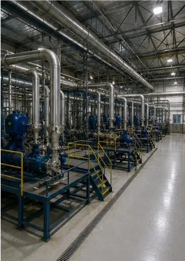
Foto №16. Gesamtüberblick über die Anlage nach Abschluss der Wartungsarbeiten
