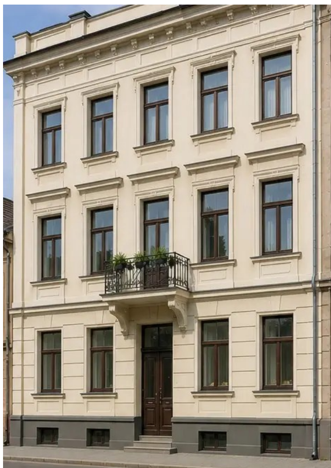
Foto №14 Gebäudefassade nach den Restaurierungsarbeiten
