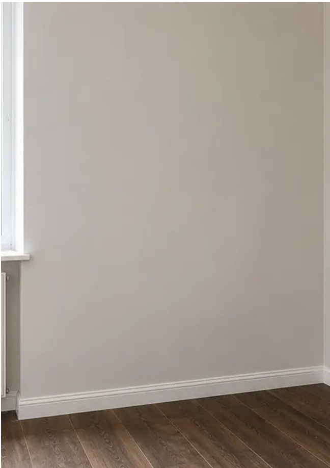
Foto №4 Zustand der Wand nach den Reparaturarbeiten
