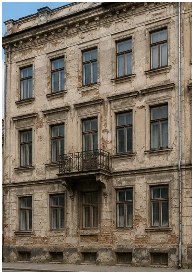
Foto №13 Gebäudefassade vor den Restaurierungsarbeiten
