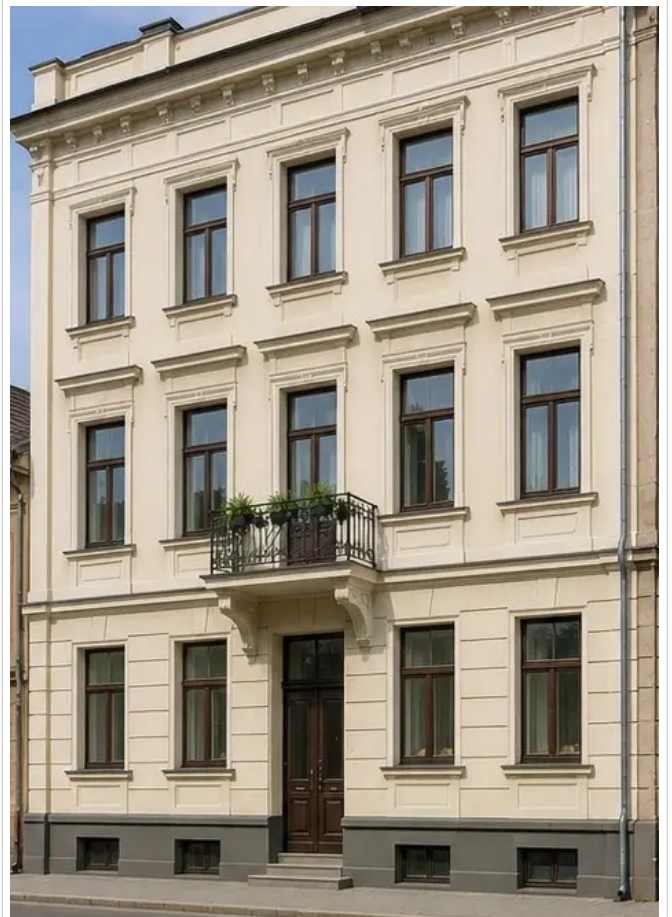
Foto №14 Gebäudefassade nach den Restaurierungsarbeiten
