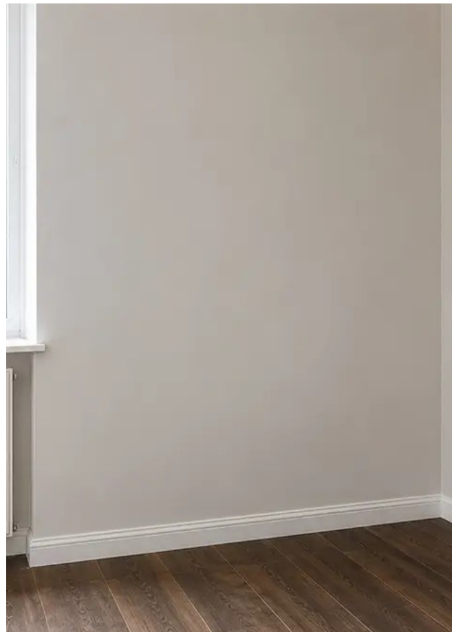
Foto №4 Zustand der Wand nach den Reparaturarbeiten
