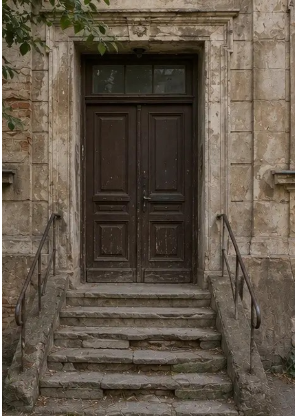
Foto №15 Eingangsbereich vor der Verbesserung
