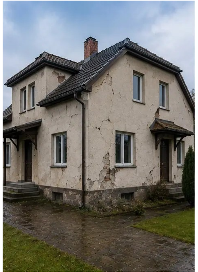
Foto №1 Gesamtansicht des inspizierten Objekts
