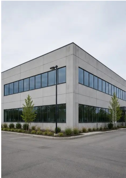
Photo #1. Gesamtansicht des inspizierten Objekts
