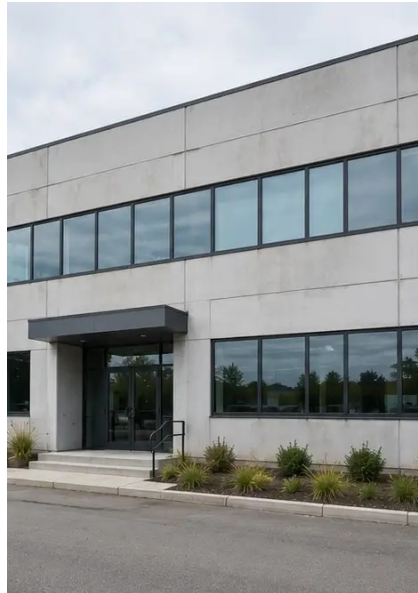
Photo #2. Zustand der Vorderfassade während der Inspektion
