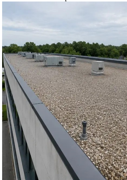
Photo #5. Dachzustandsinspektion abgeschlossen
