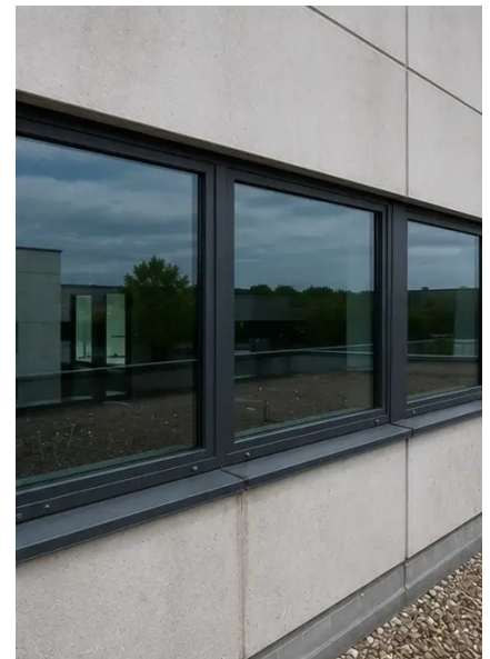
Photo #6. Zustand der Fenster bei der Inspektion dokumentiert
