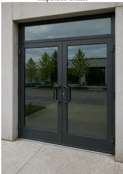
Photo #7. Zustand der Türen inspiziert und erfasst
