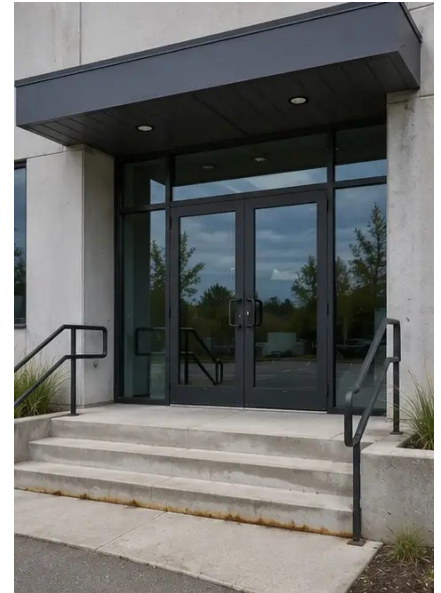
Photo #3. Haupteingangsbereich inspiziert und dokumentiert
