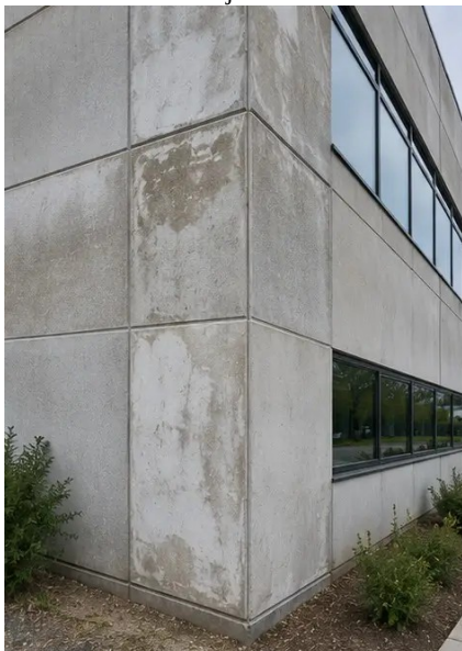
Photo #4. Zustand der Außenwände bei der Inspektion erfasst
