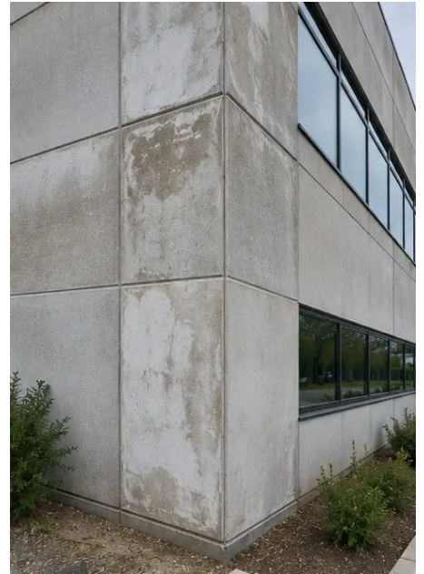
Photo #4. Zustand der Außenwände bei der Inspektion erfasst
