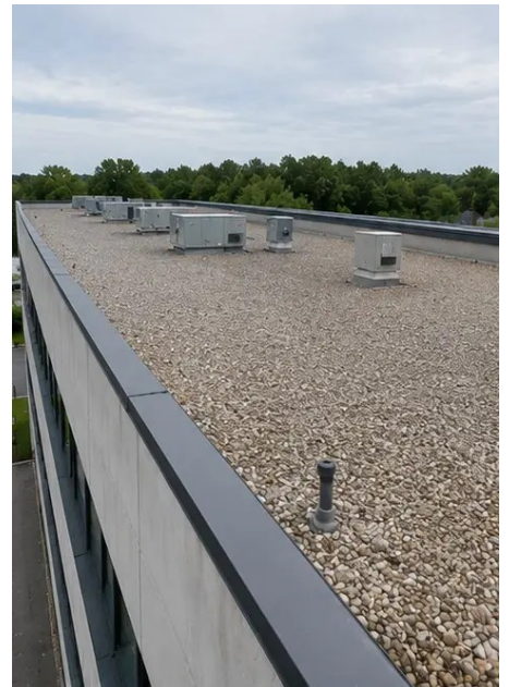
Photo #5. Dachzustandsinspektion abgeschlossen
