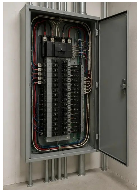
Photo #9. Zustand des Elektroverteilers dokumentiert
