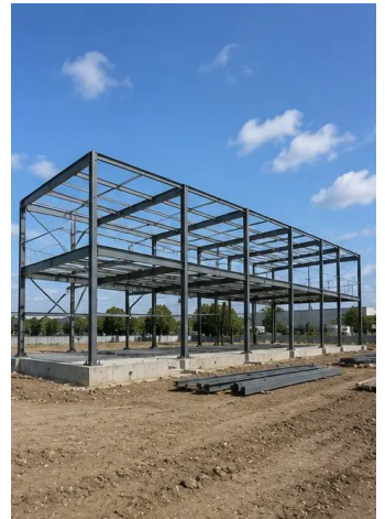
Foto №7. Errichtung des Tragwerks im Gange
