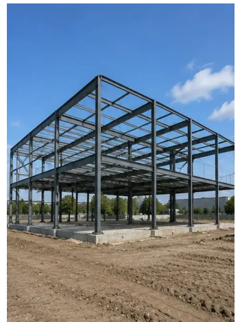
Foto №8. Tragwerk gemäß Projektzeitplan fertiggestellt
