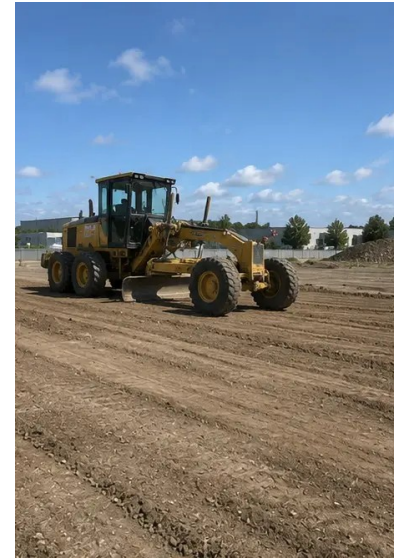
Foto №3. Räumung und Planierung des Geländes abgeschlossen
