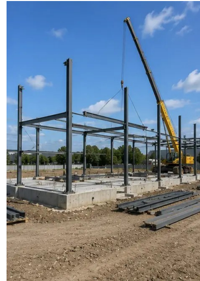
Foto №6. Montage des Tragwerks begonnen
