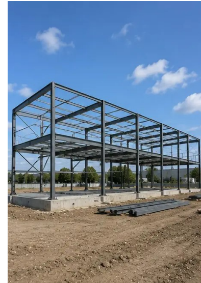
Foto №7. Errichtung des Tragwerks im Gange
