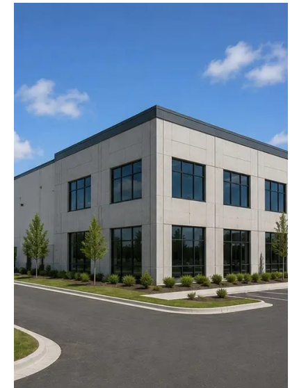
Foto №16. Abgeschlossenes Projekt betriebsbereit
