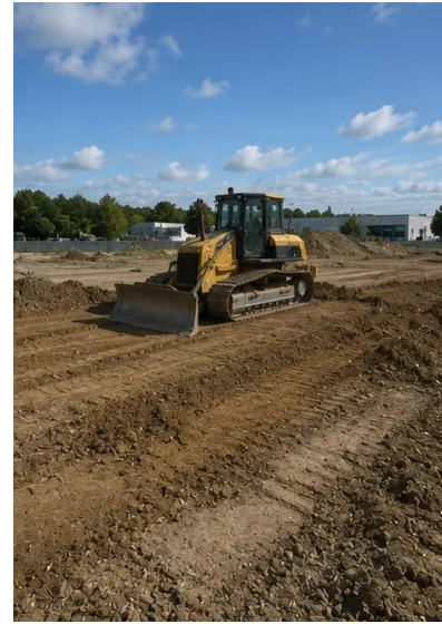
Foto №2. Baustelleneinrichtungsarbeiten im Gange
