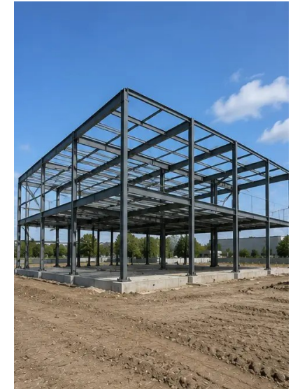
Foto №8. Tragwerk gemäß Projektzeitplan fertiggestellt
