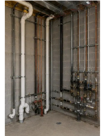
Foto №12. Sanitärinstallation abgeschlossen
