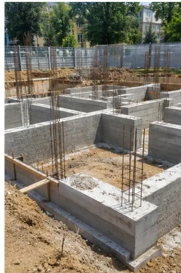
Foto №3 Fundamentbauarbeiten im Gange
