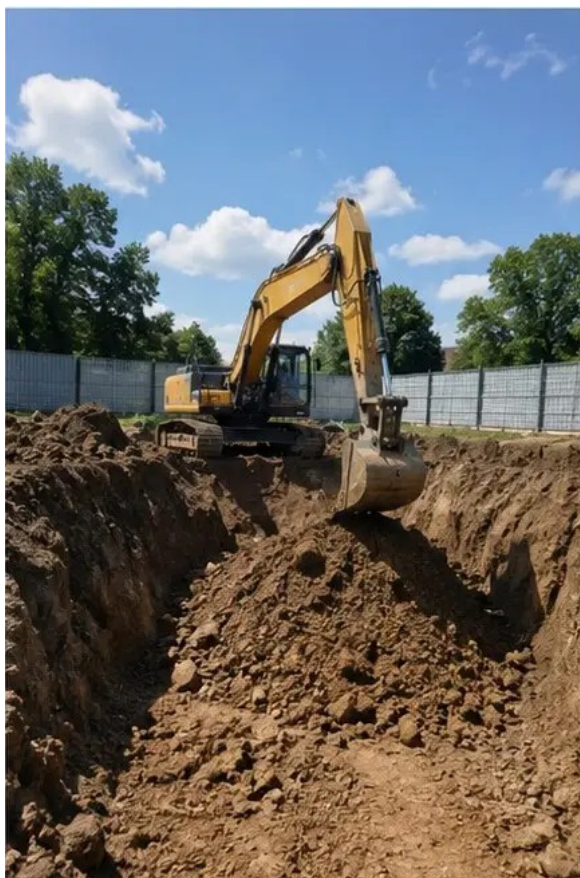
Foto №2 Aushubarbeiten gemäß Projektanforderungen durchgeführt
