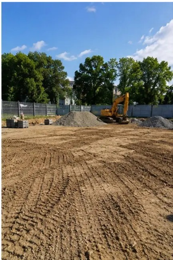
Foto №1 Vorbereitende Arbeiten auf der Baustelle vor Baubeginn abgeschlossen
