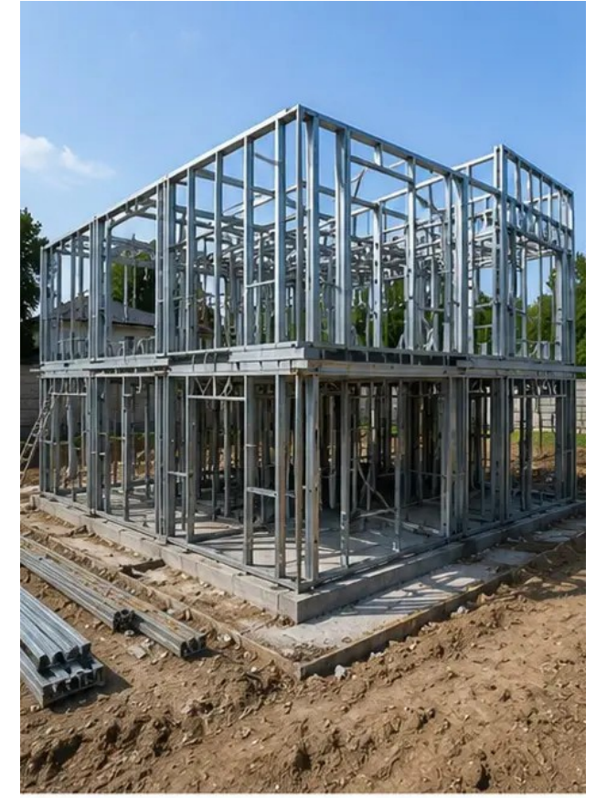
Foto №6 Montage des Tragwerks im Gange
