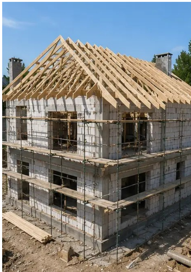
Foto №8 Dachinstallationsarbeiten abgeschlossen
