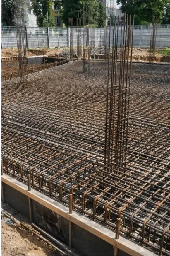
Foto №4 Bewehrungsinstallation vor dem Betonieren abgeschlossen
