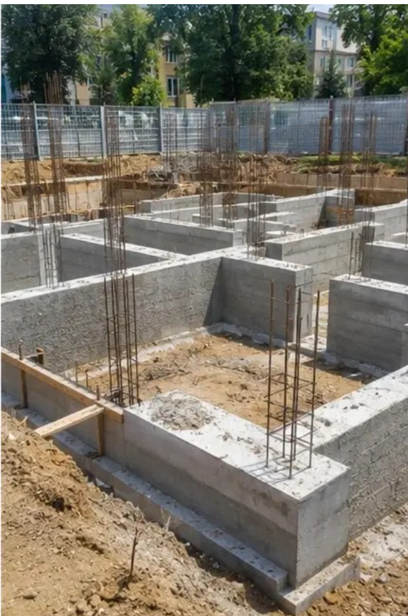
Foto №3 Fundamentbauarbeiten im Gange
