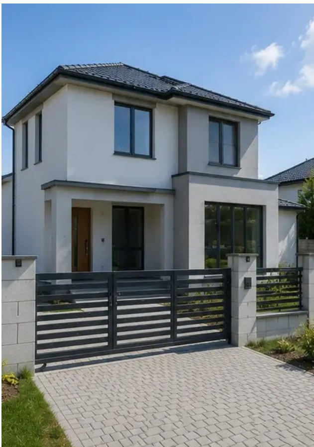
Foto №15 Fertiges Gebäudeäußeres nach Baufertigstellung
