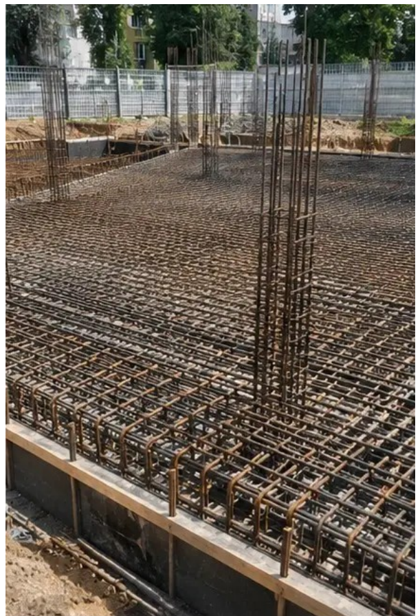
Foto №4 Bewehrungsinstallation vor dem Betonieren abgeschlossen
