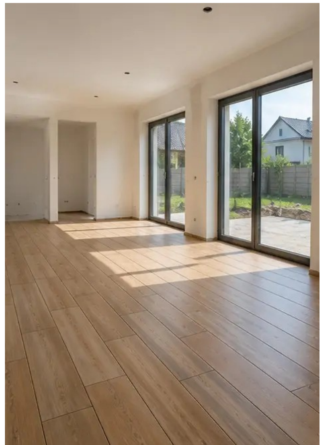
Foto №12 Bodenbelagsarbeiten gemäß Projektspezifikationen abgeschlossen
