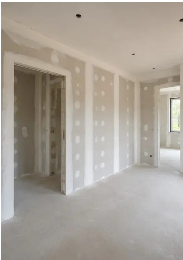
Foto №11 Innenwandausbauarbeiten im Gange
