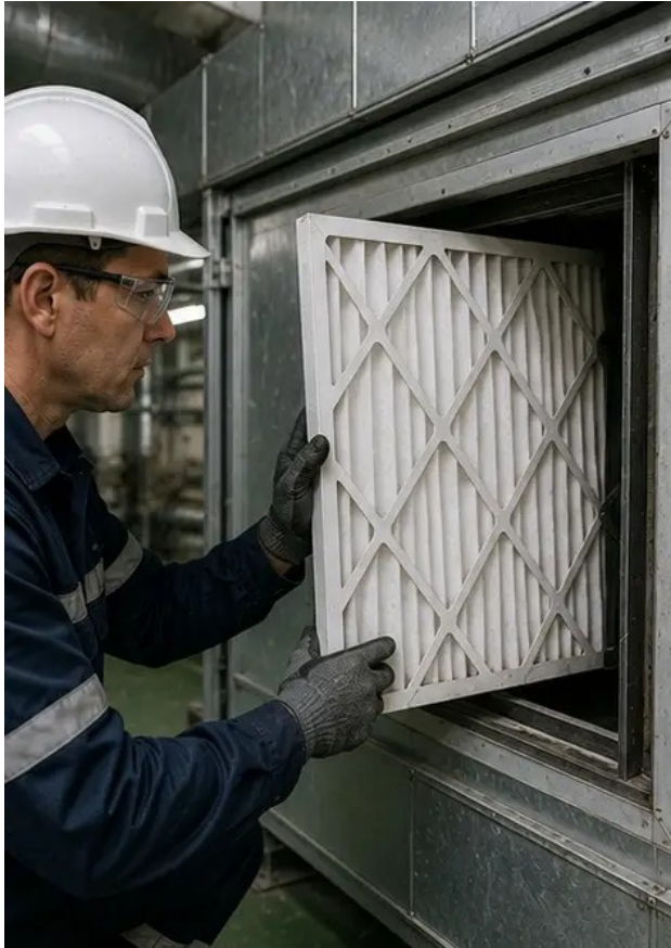
Foto nr.7. Udskiftning af luftfilter afsluttet
