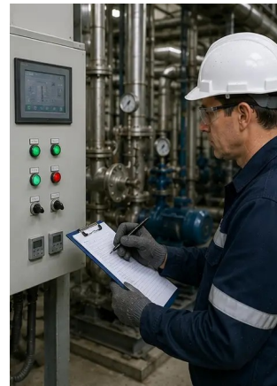
Foto nr.14. Afsluttende vedligeholdelsesverifikation udført
