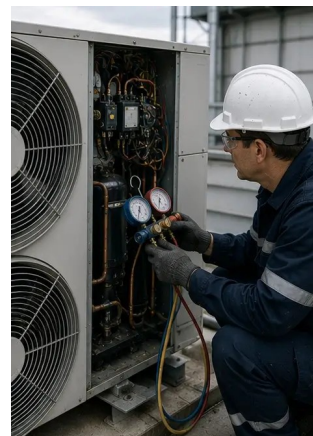
Foto nr.6. HVAC-udstyrs tilstand dokumenteret
