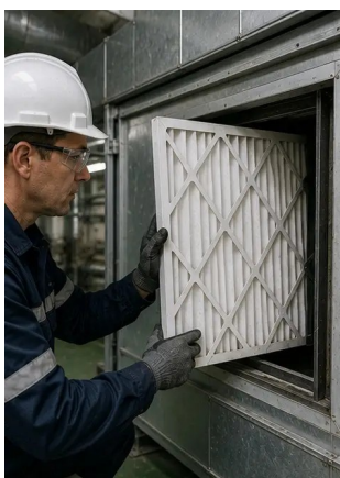
Foto nr.7. Udskiftning af luftfilter afsluttet
