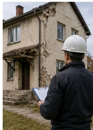
Photo #16. Afsluttende oversigtsfoto af skadesinspektion
