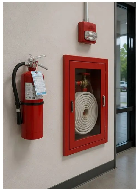
Photo #12. Sikkerhedsudstyr inspiceret og registreret
