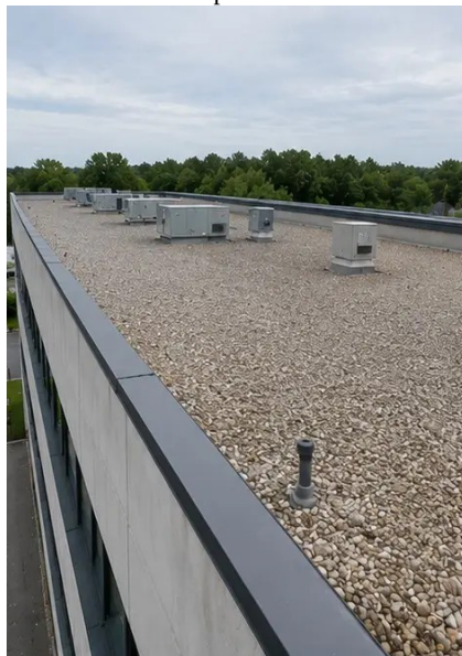
Photo #5. Taginspektion afsluttet
