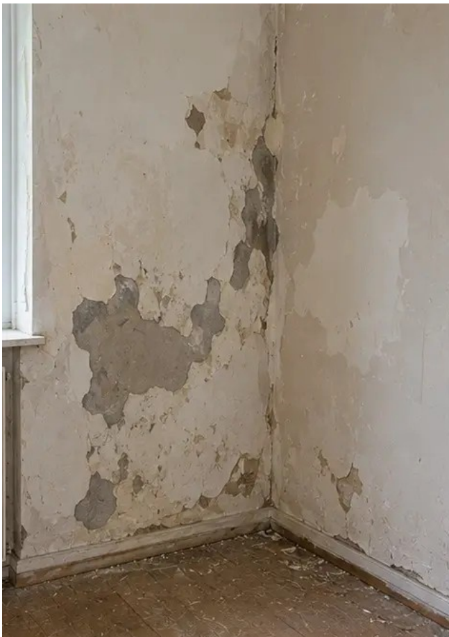
Foto nr.3 Væggens tilstand før reparation
