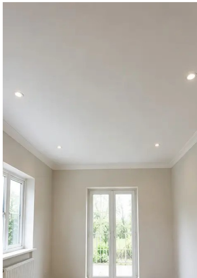
Foto nr.8 Loftets tilstand efter renovering
