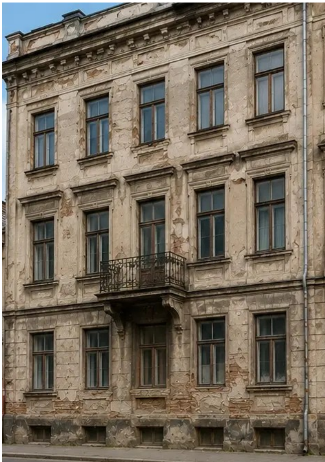
Foto nr.13 Bygningens facade før restaurering
