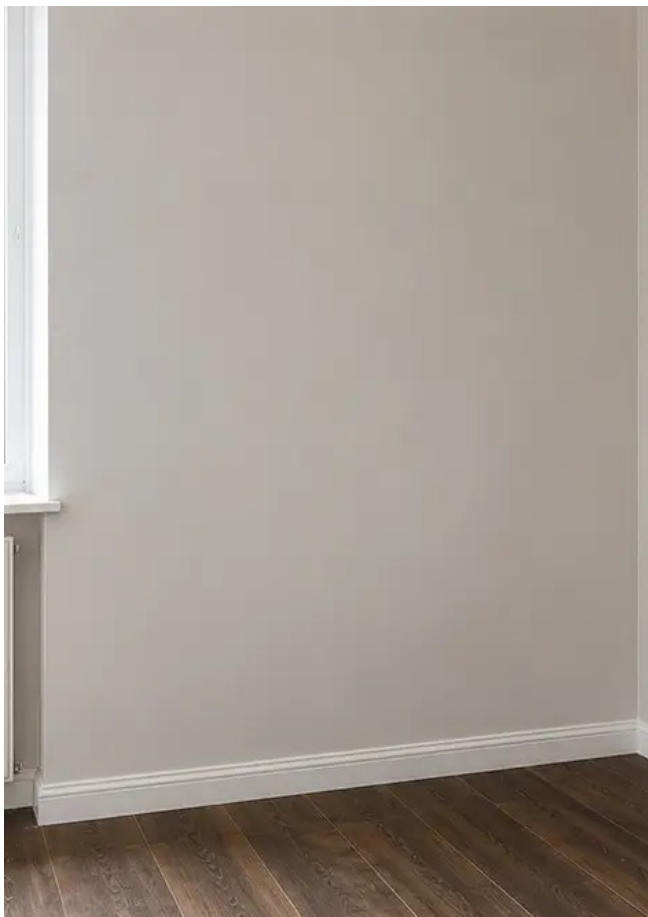
Foto nr.4 Væggens tilstand efter reparation
