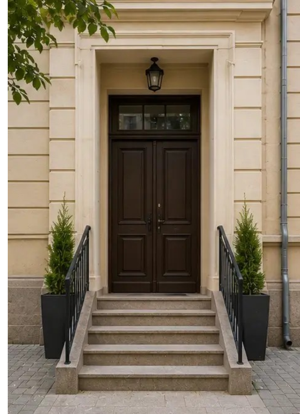
Foto nr.16 Ejendommens indgang efter forbedring
