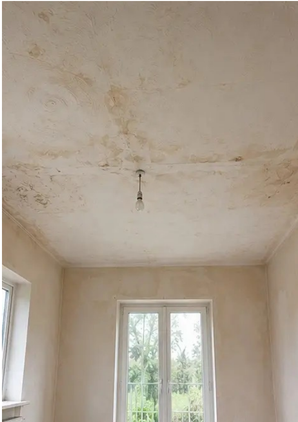
Foto nr.7 Loftets tilstand før renovering
