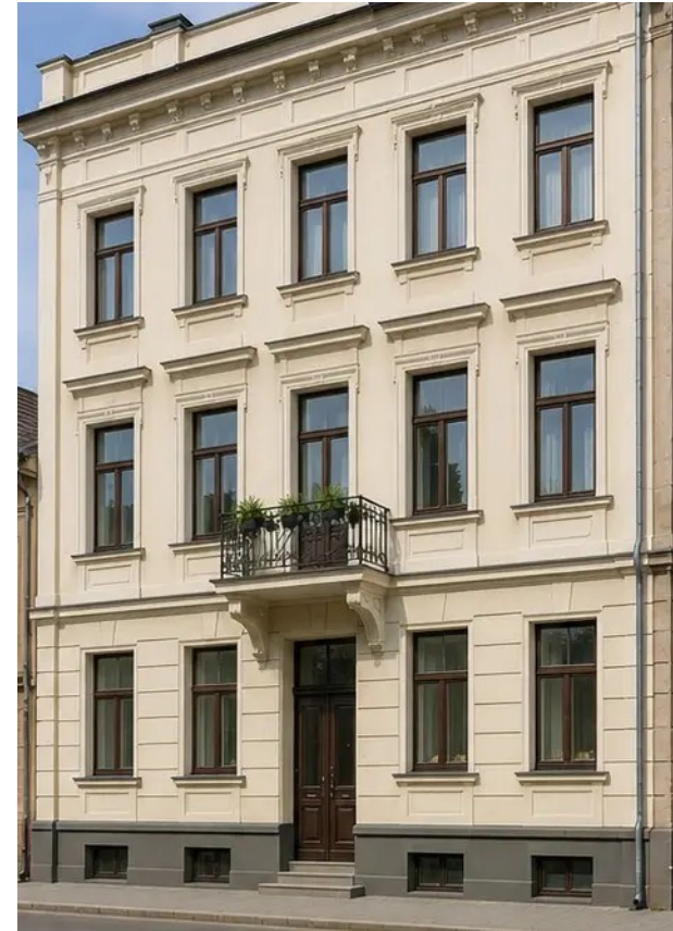
Foto nr.14 Bygningens facade efter restaurering
