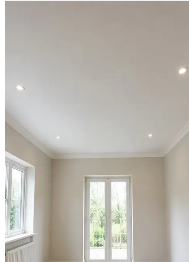
Foto nr.8 Loftets tilstand efter renovering
