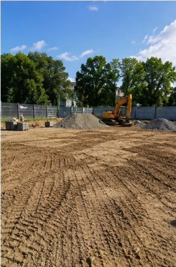
Foto nr.1 Forberedende arbejder på byggepladsen afsluttet før byggestart
